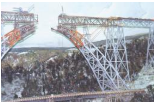
Prikaz gradnje Mungstenerjevega mostu - 1897
